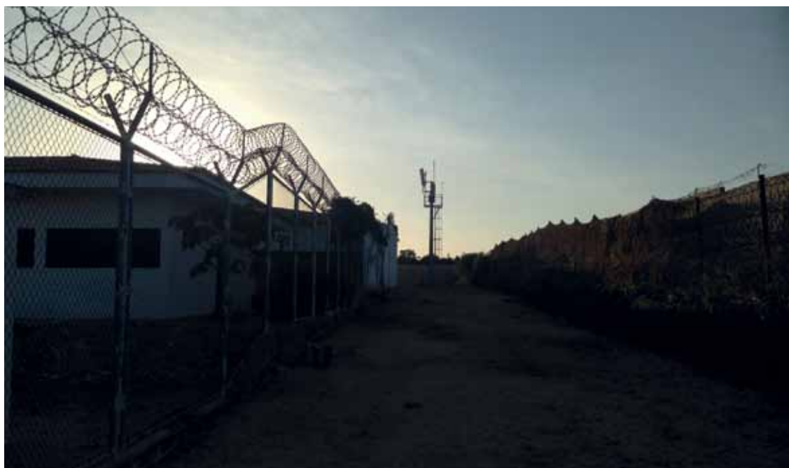
Sistema para bloqueio de comunicações (à esq.) na Penitenciária Estadual de Parnamirim, no Rio Grande do Norte, e a instalação de uma das torres e equipamentos no mesmo presídio (à dir.)
